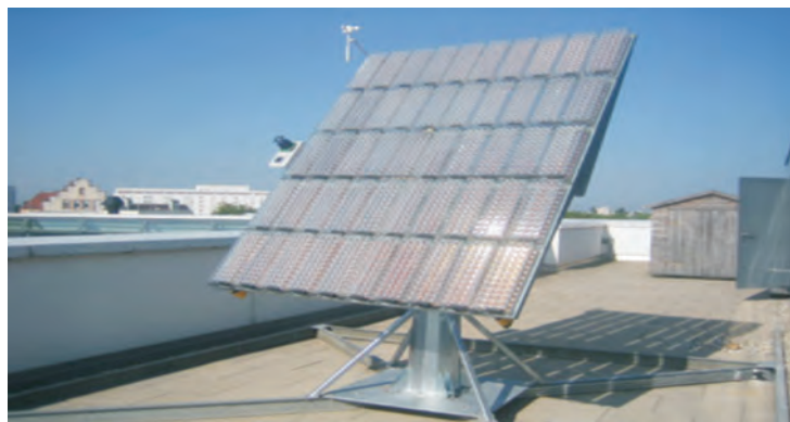
Рисунок 2 – Система ВФУ с использованием линз Френселя
