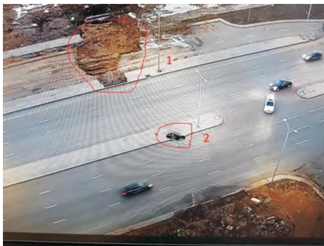
Рисунок 2 – Провалы в результате промерзания-оттаивания по г. Астане
