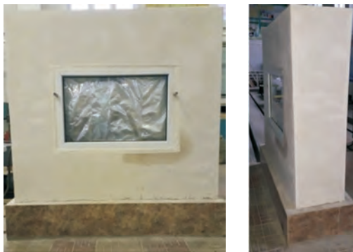
Рисунок 2 – Общий вид фрагмента стенового ограждения
